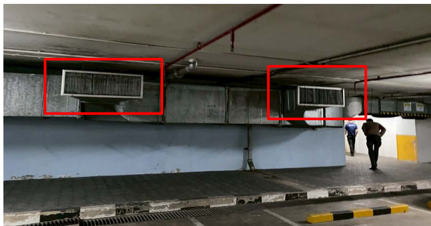
รูปที่ 2.2-15 ระบบระบายอากาศบริเวณชั้นใต้ดิน เพื่อให้เกิดการหมุนเวียนของอากาศ จากภายนอกสู่ภายในอาคาร โดยติดตั้งพัดลมระบายอากาศ
